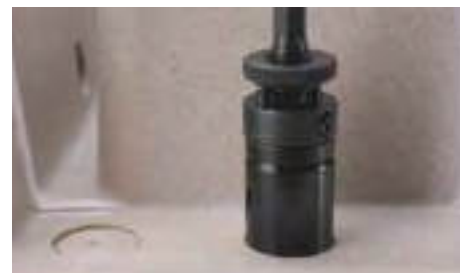
Fig. C - Procedere con il completamento del foro
