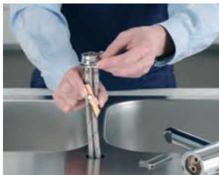
Infilare (dall'alto) la base universale "Semplifix" system nel foro del lavello.
